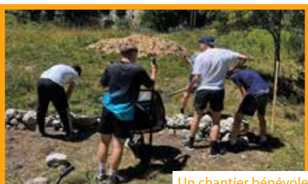
Un chantier bénévole
