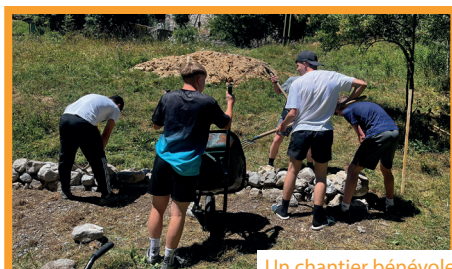
Un chantier bénévole
